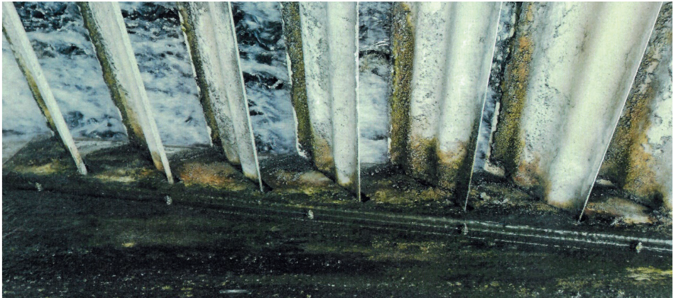
1. ábra: A hűtőtorny belsejében levő lamellák
